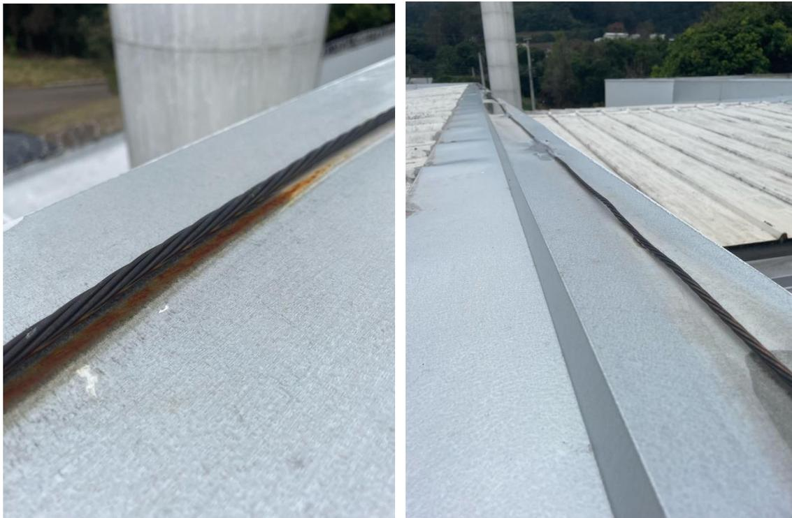
*Figuras 1 e 2: Cabo de cobre em contato com rufo*
